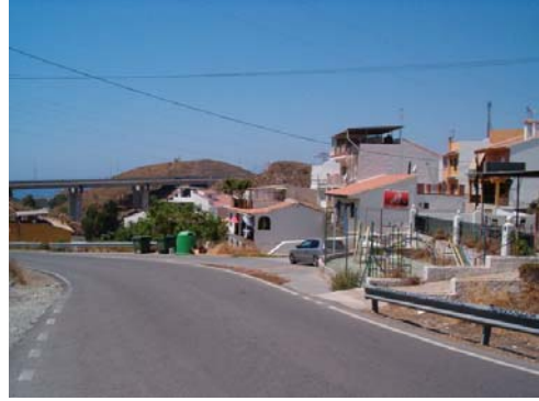
Carretera actual. Viaducto ronda circunvalación.
