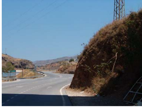
Inicio Carretera Olías
