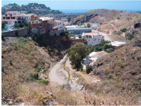
Cauce Arroyo Gálica y zona consolidada
