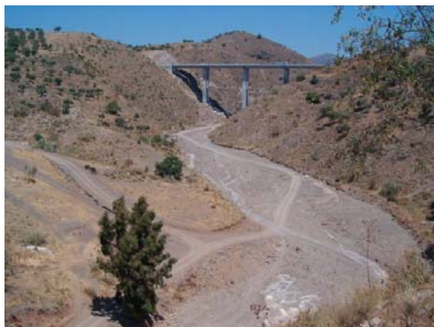
Arroyo Gálica y viaducto autovía
